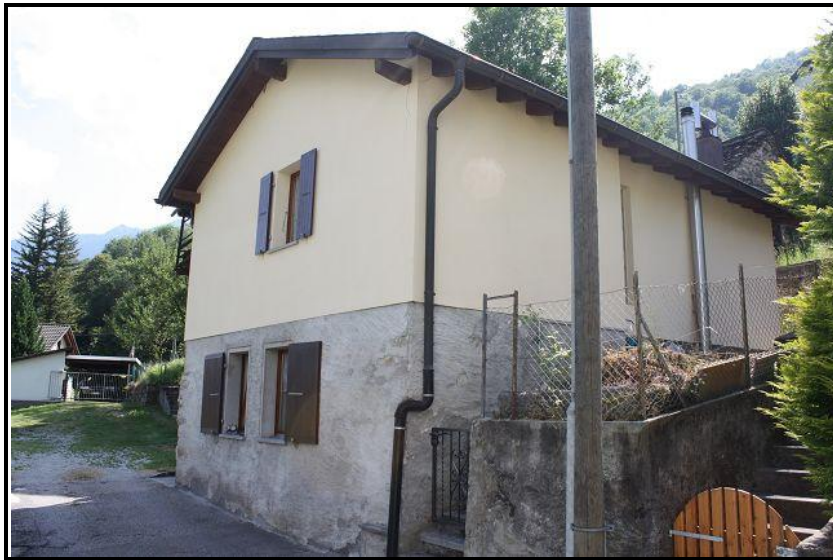
Facciata nord / Nordfassade
