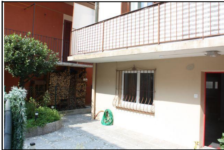
Cortile e balcone / Hof und Balkon
