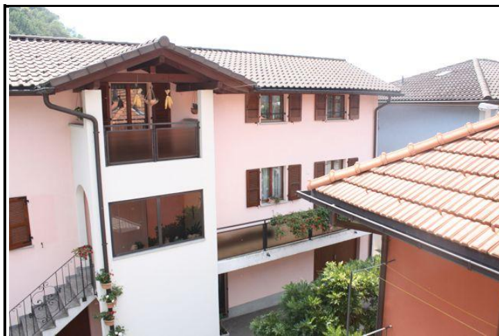
Vista sud / Südblick
