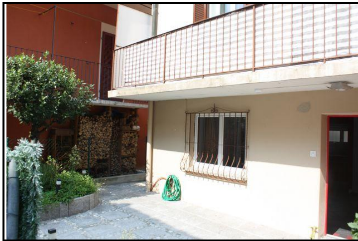
Cortile e balcone / Hof und Balkon
