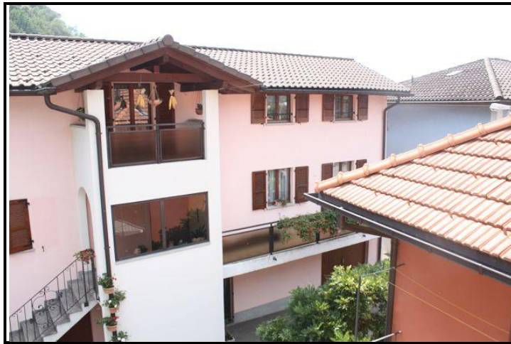
Vista sud / Südblick
