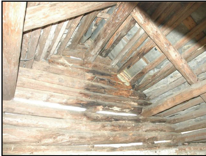
Rustico tetto / Rustico Dachstuhl
