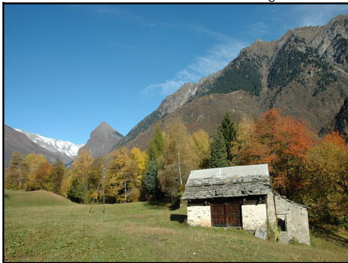
Facciata sud / Südfasade
