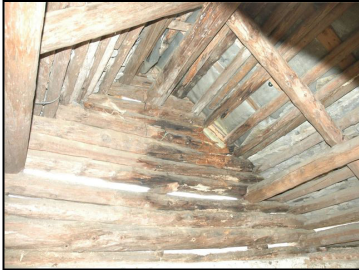
Rustico tetto / Rustico Dachstuhl
