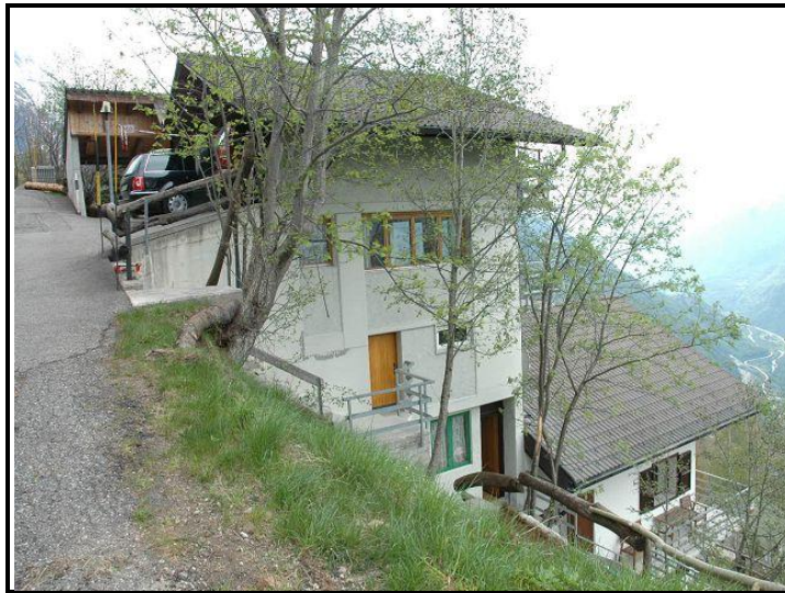
Facciata est / Westfassade
