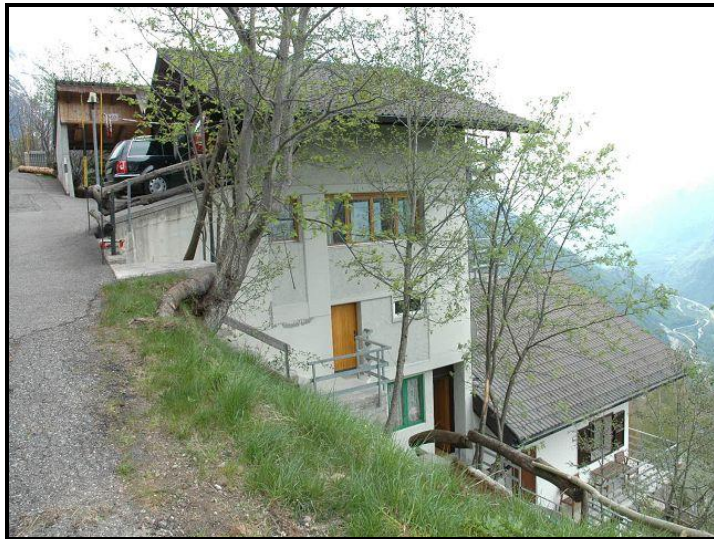
Facciata est / Westfassade
