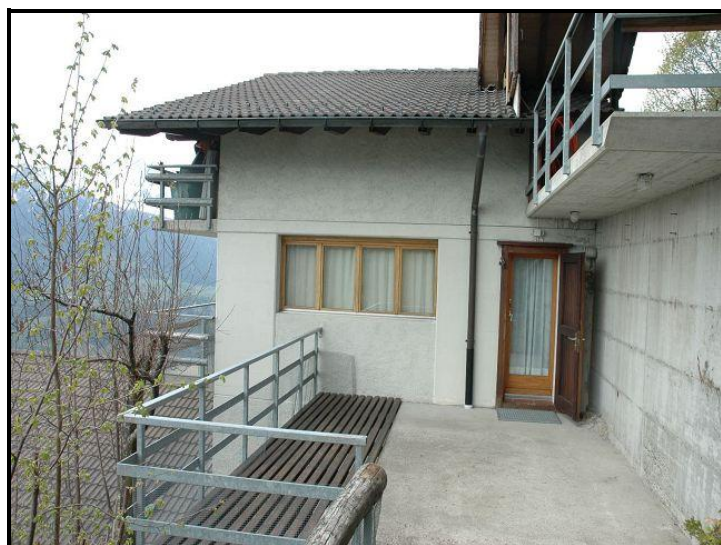
Terrazza sopra / Terrasse der Dachwohnung
