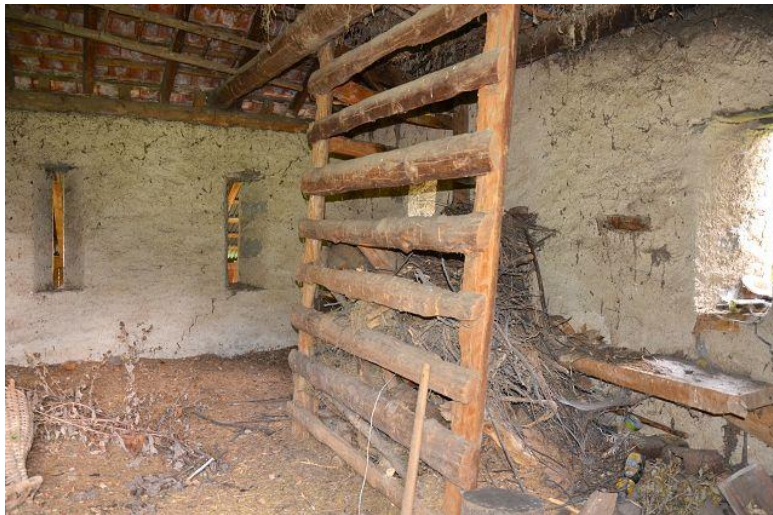
Innenraum Obergeschoss / interno primo piano
