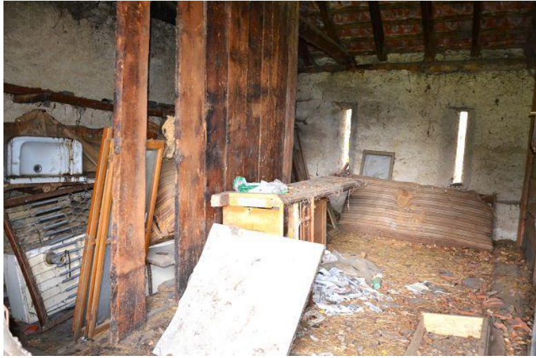
Innenraum Obergeschoss / interno primo piano
