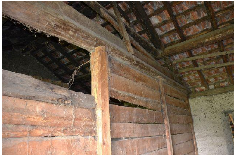
Innenraum Obergeschoss / interno primo piano
