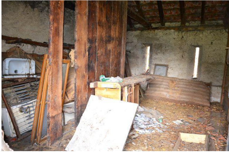
Innenraum Obergeschoss / interno primo piano
