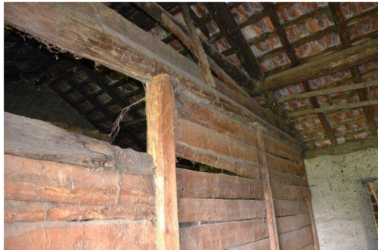
Innenraum Obergeschoss / interno primo piano
