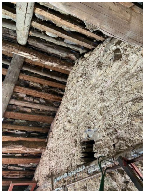
Unterdach und Mauerwerk / sotto tetto e muro
