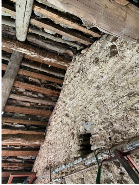
Unterdach und Mauerwerk / sotto tetto e muro
