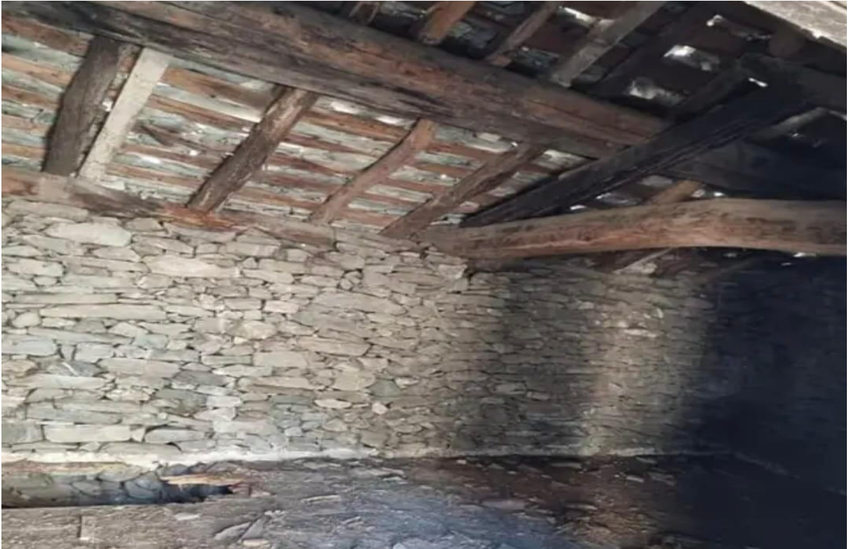
Innenbereich Erdgeschoss / interno piano terra
