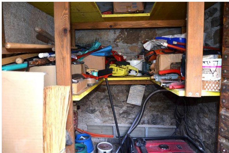
Technischer Raum / locale tecnico
