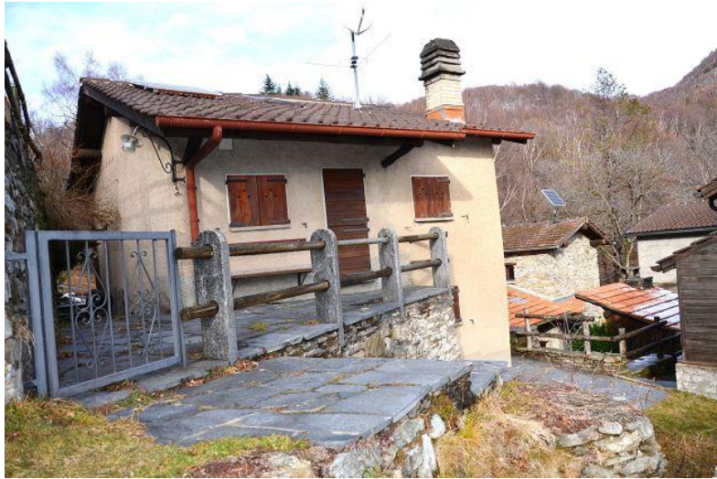
Haus und Terrasse / casa e terrazza
