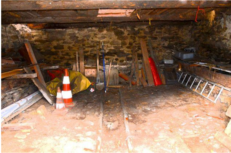
Innenbereich EG / interni PT
