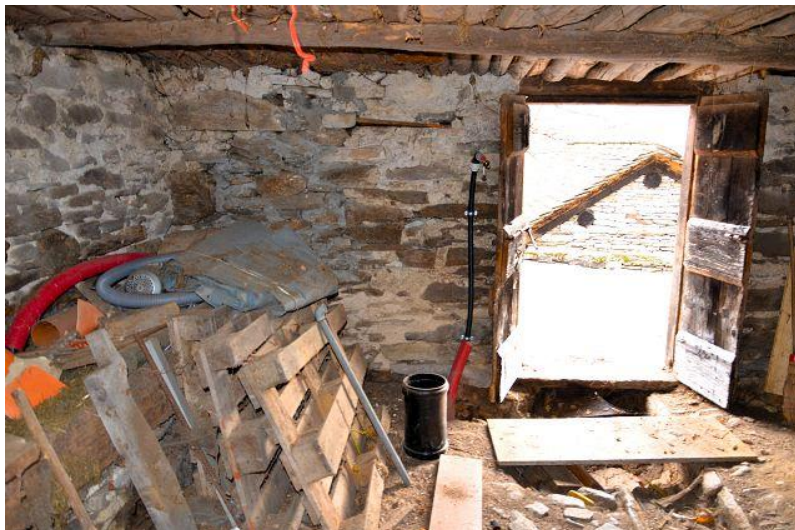
Innenbereich EG / interni PT
