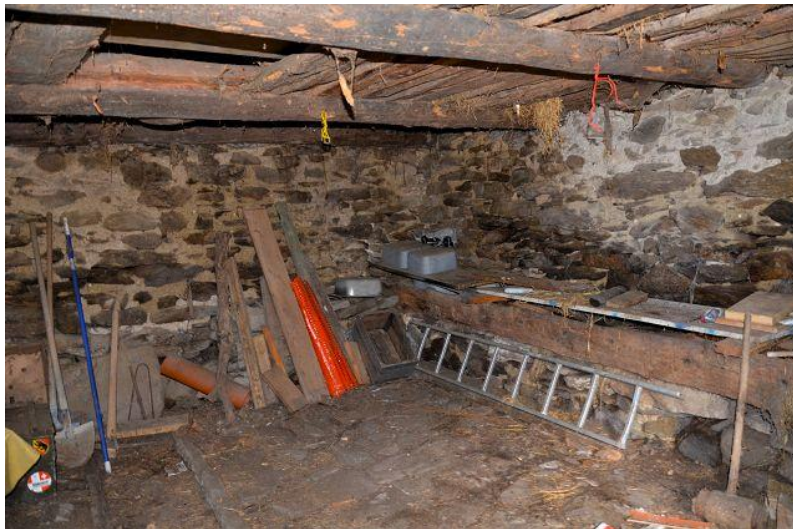
Innenbereich EG / interni PT
