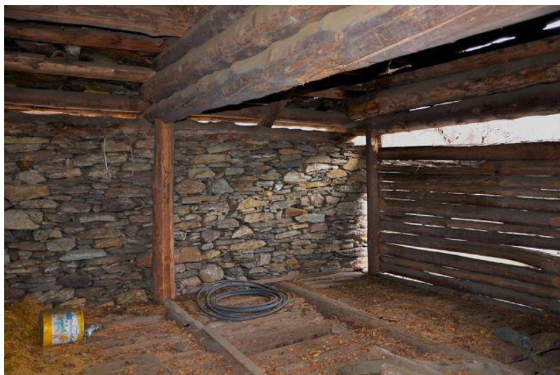
Innenbereich 1.OG / interni PP
