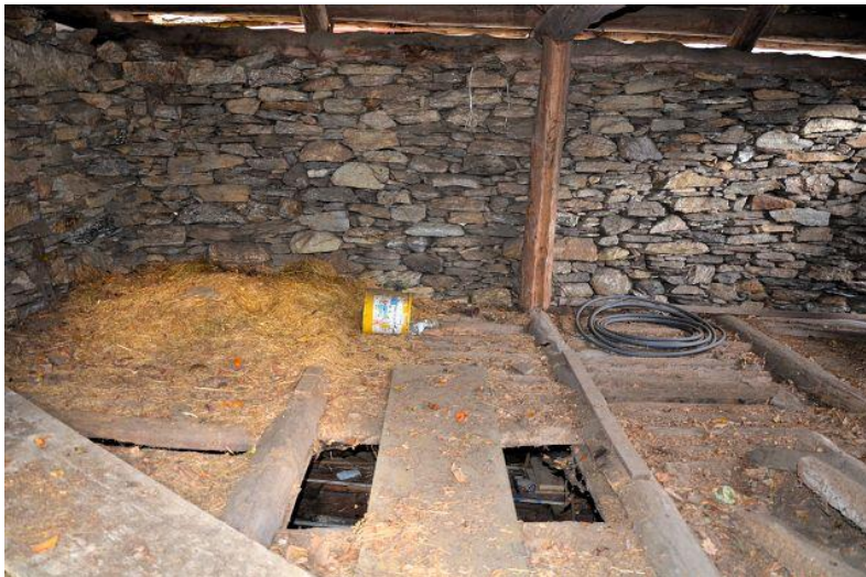
Innenbereich 1.OG / interni PP
