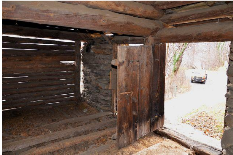
Innenbereich 1.OG / interni PP
