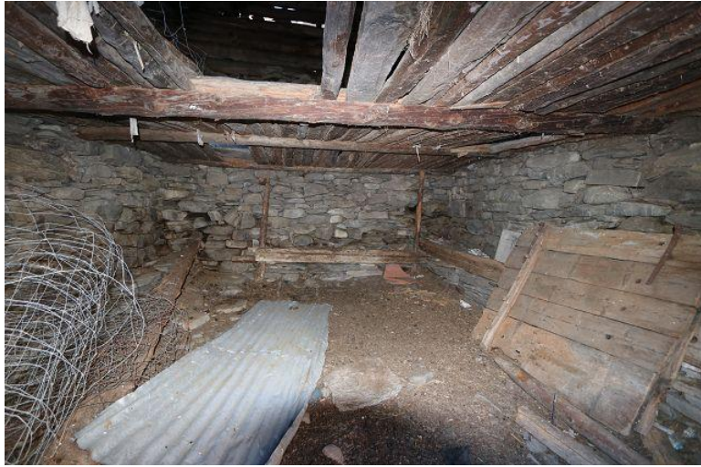
Innenraum EG / interno PT
