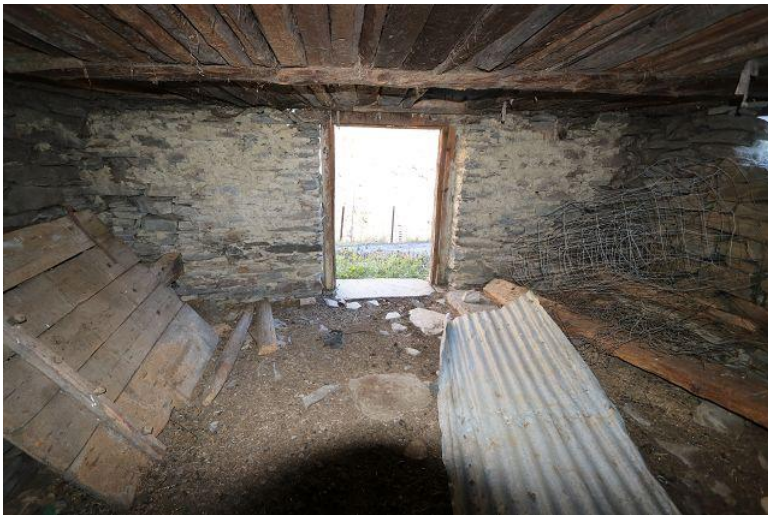
Innenraum EG / interno PT
