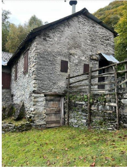
Haupteingang und Kellereingang / entrata casa e cantina
