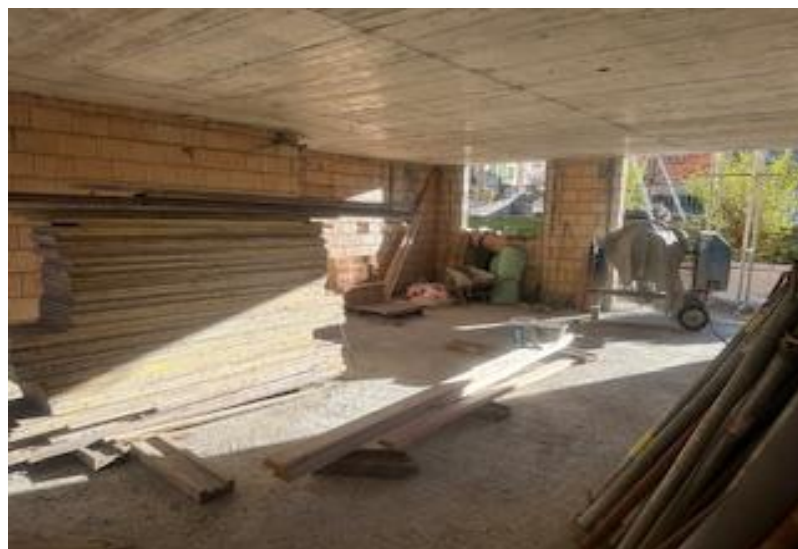
Innenbereich EG / interni PT
