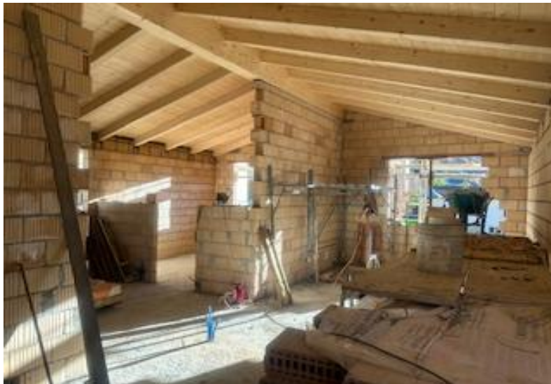
Innenbereich 1. OG / interni PP
