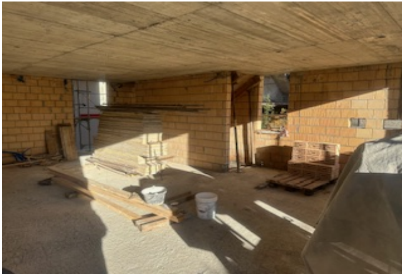
Innenbereich EG / interni PT
