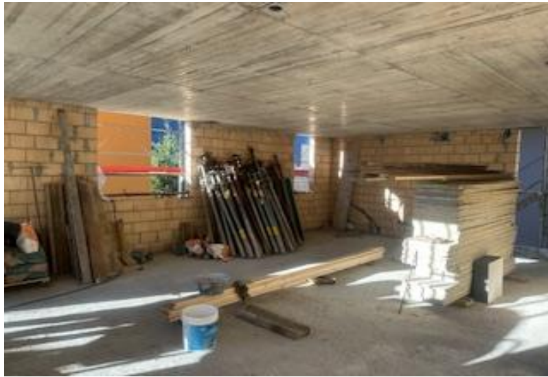
Innenbereich EG / interni PT
