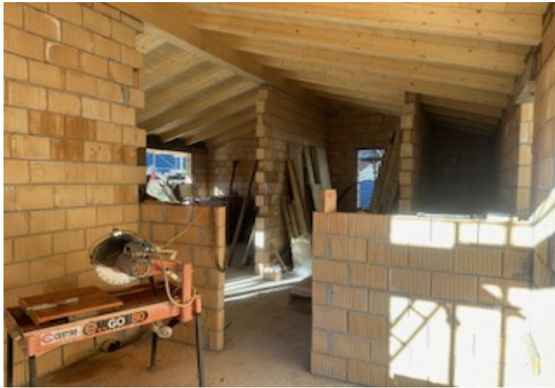
Innenbereich 1. OG / interni PP
