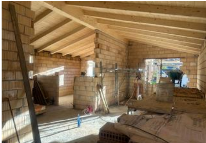
Innenbereich 1. OG / interni PP
