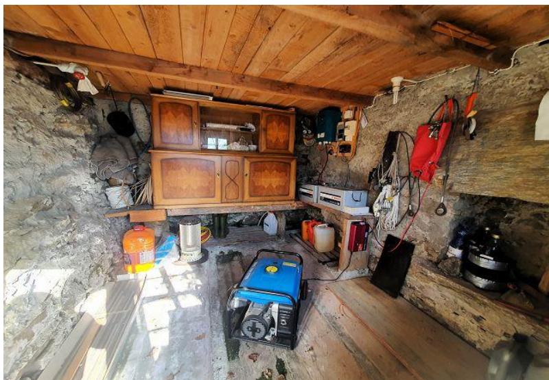
Technischerraum / locale tecnico
