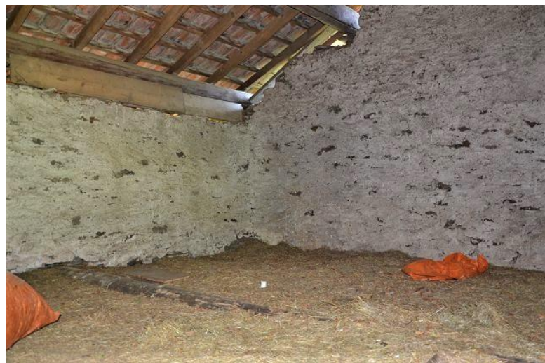
Dachraum / primo piano
