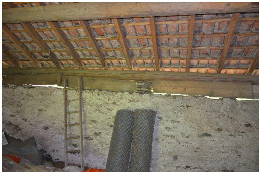
Dachraum / primo piano
