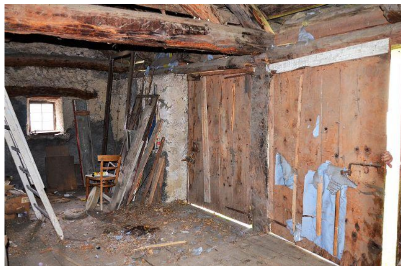
Innenbereich 1. OG / interni PP
