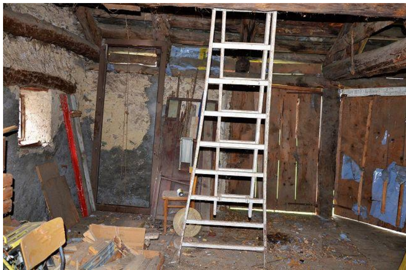
Innenbereich 1. OG / interni PP
