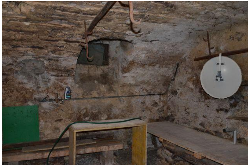
Keller Haus Ost / cantina casa est
