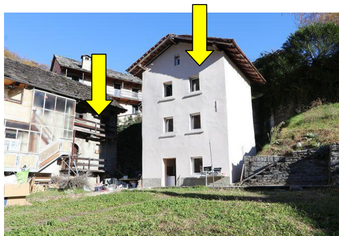
4-Zimmer-Haus mit Hausteil / casa di 4 locali con rustico
