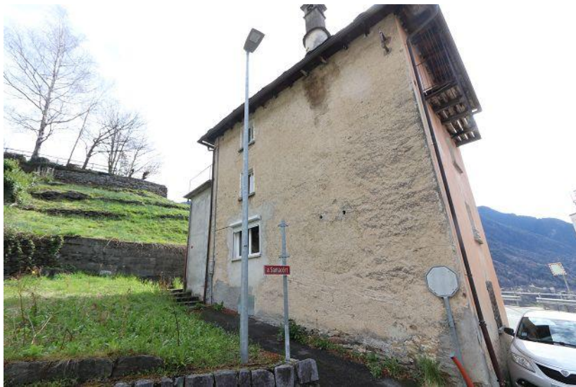
Haus Ost / casa est
