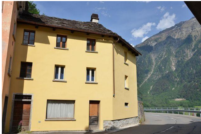
Haus Ost / casa est
