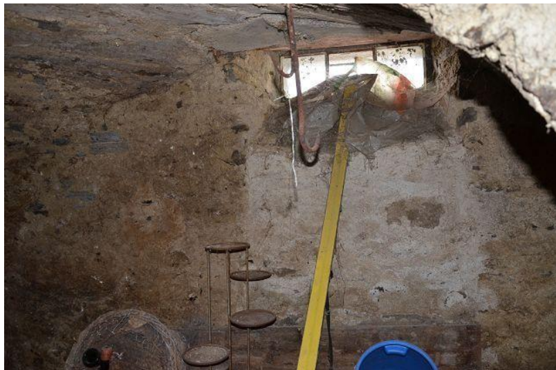
Keller Haus West / cantina casa ovest
