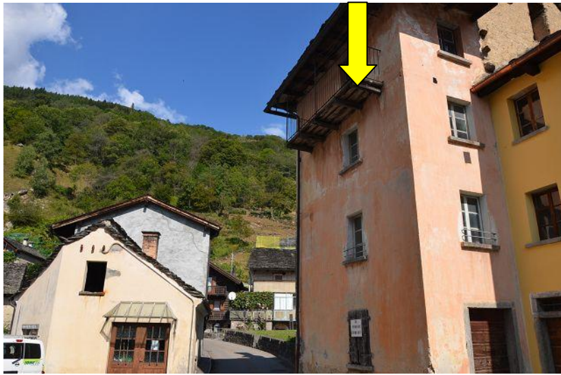
Haus Ost / casa est
