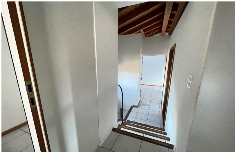
Korridor im zweiten Stock / Corridoio al secondo piano
