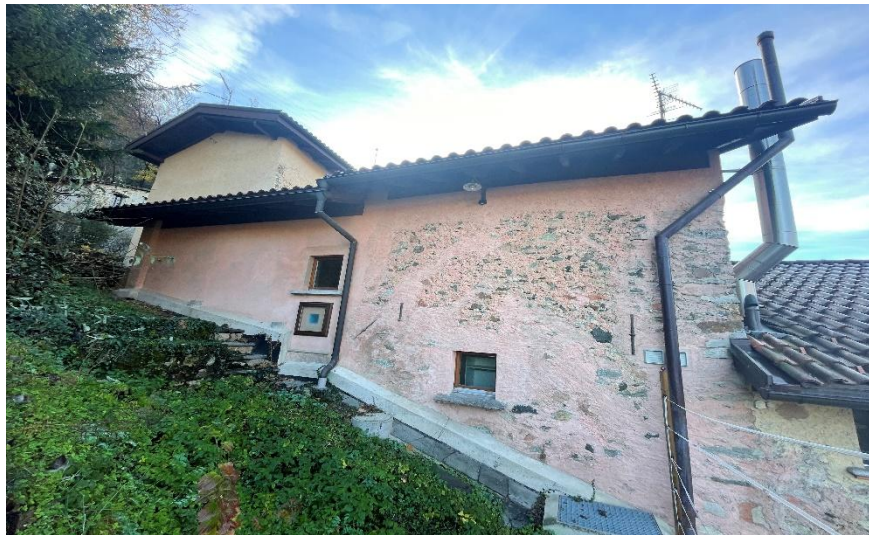
Gebäude von der Rückseite / Edificio dal retro
