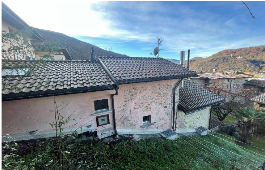
Gebäude von der Rückseite / Edificio dal retro
