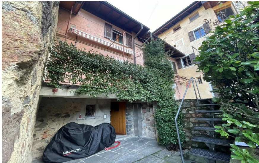
Eingang zum Erdgeschoss / Ingresso al pianterreno
