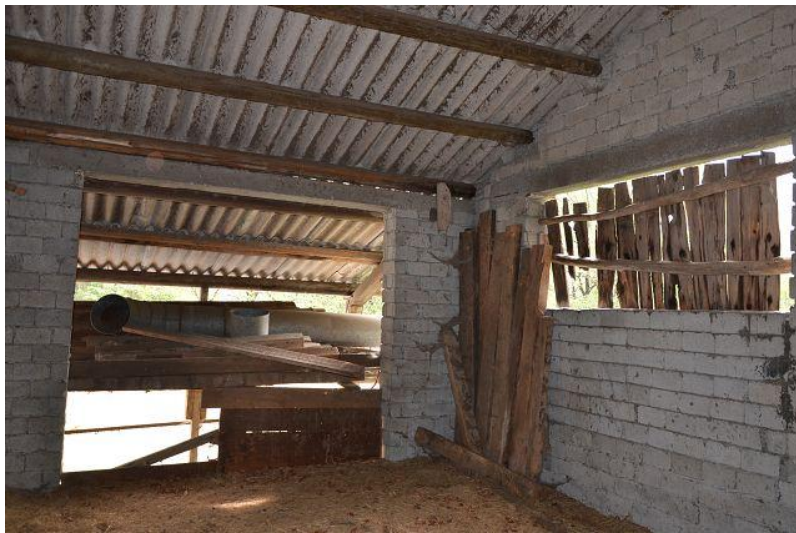
Innenraum Stall / interni stalla
