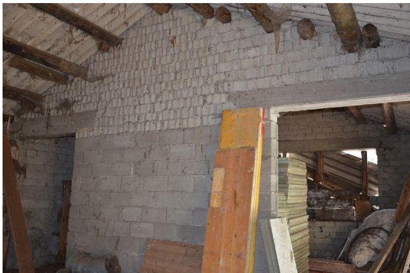
Innenraum Stall / interni stalla
