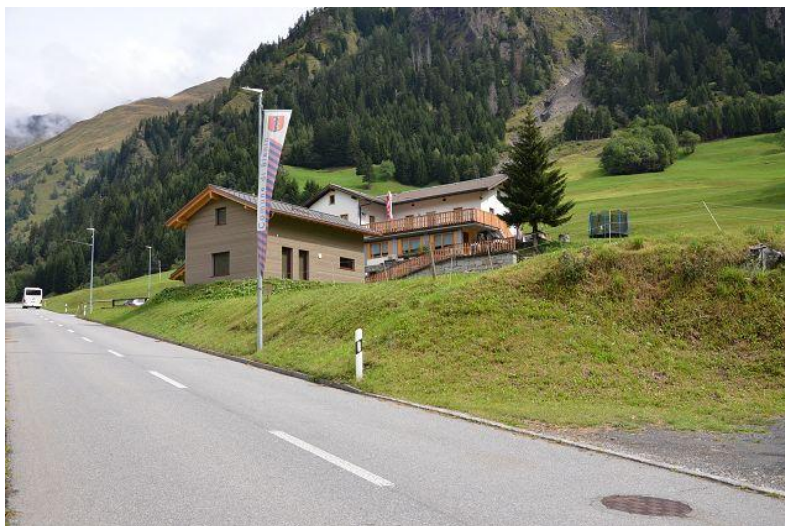
Grundstück direkt an der Strasse / terreno direttamente sulla strada
