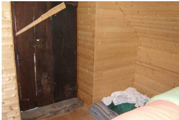
Eingangstür zum Zimmer / ingresso della camera
