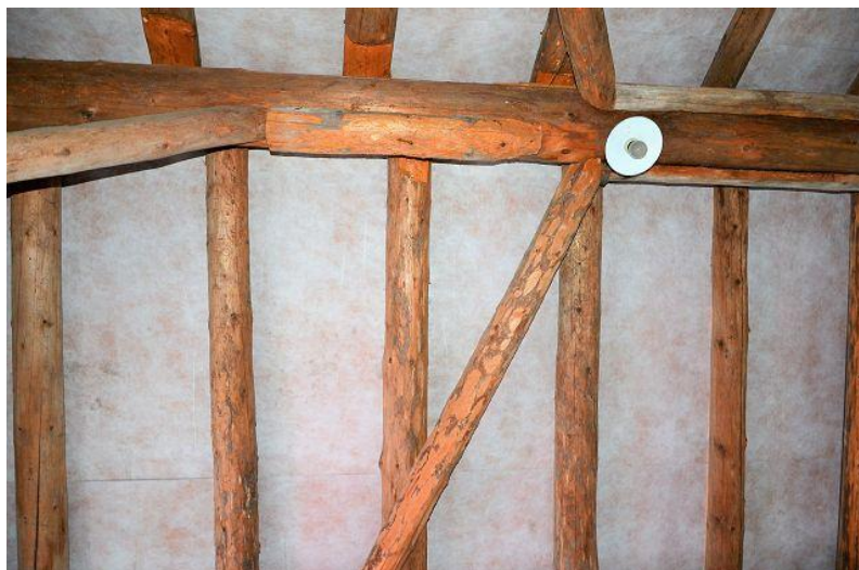
Dachuntersicht / sotto tetto
