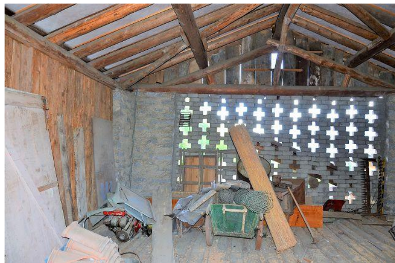
Dachraum / locale sotto tetto
