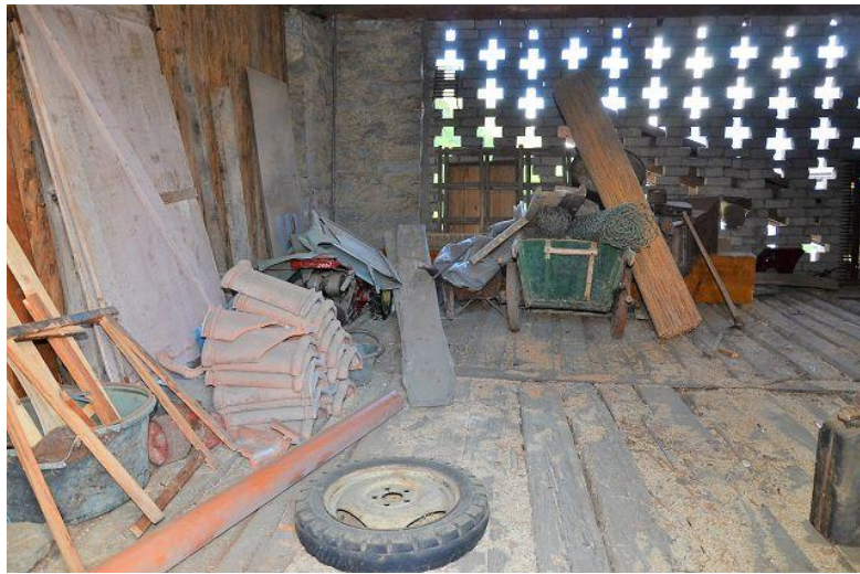
Dachraum / locale sotto tetto
