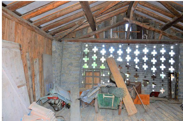
Dachraum / locale sotto tetto
