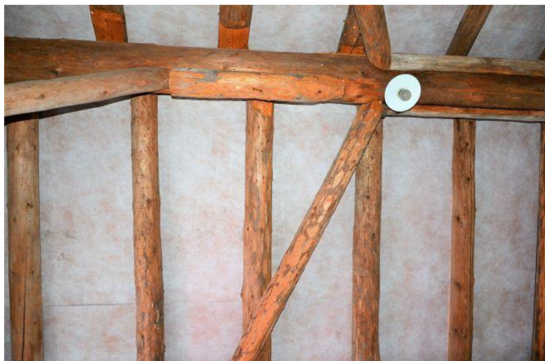
Dachuntersicht / sotto tetto
