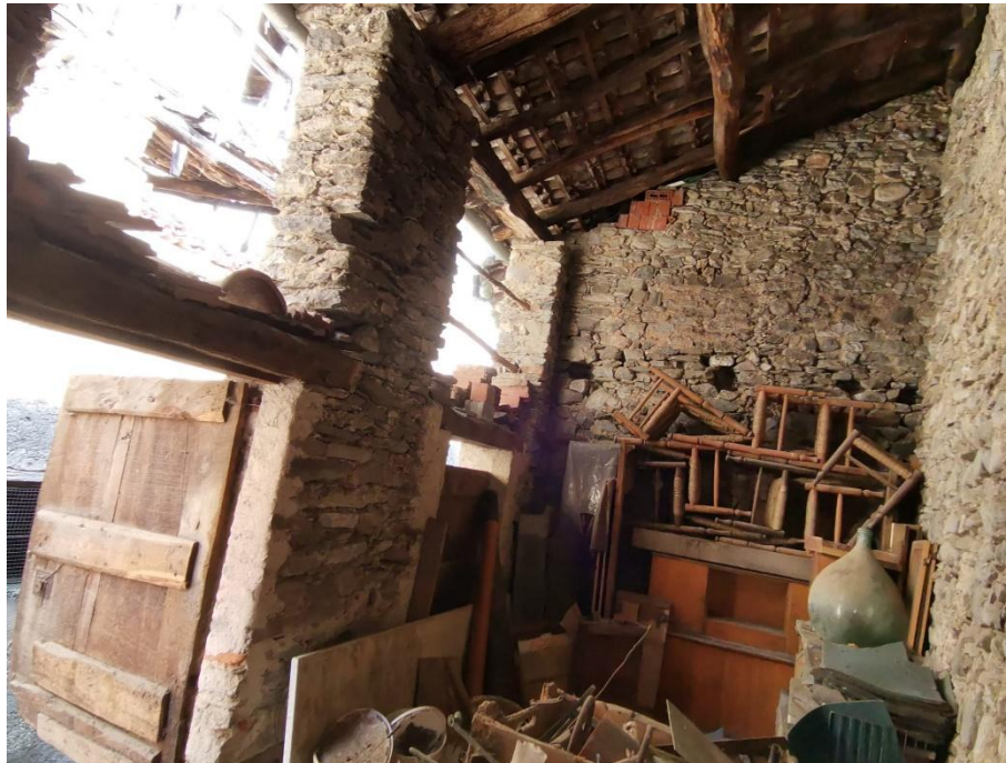
Innenraum kleines Rustico / interno rustico piccolo
