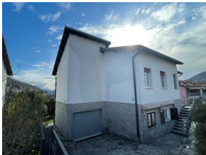
Eingang zum Gebäude mit Garage/ Ingresso all'edificio con garage
