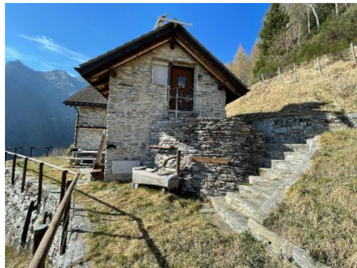
Eingang zum OG / l'ingresso al piano sopra
