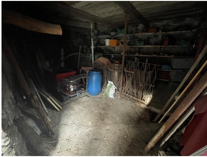
Zimmer im 1. Stock des Gebäudes/ Camera al 1° piano dell'edificio
