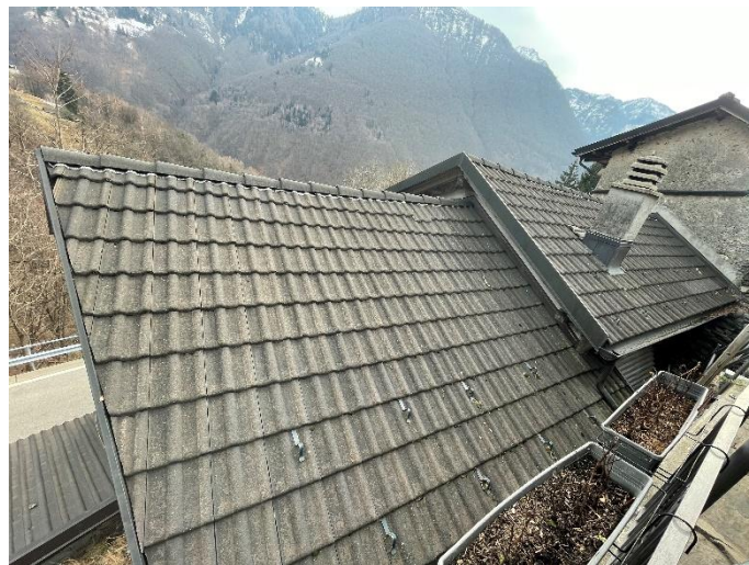
Dachbaustoffe Glasbeton, / Tetto dei materiali da costruzione cemento
