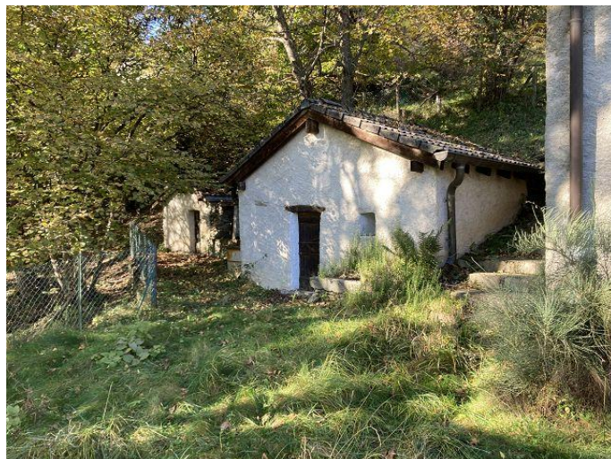
Rustici Dusche und Keller / rustici doccia e cantina
