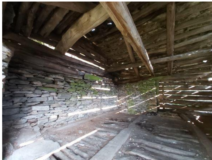
Dachgeschoss / sotto tetto
