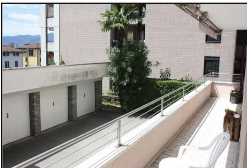
Terrazza coperta / gedeckte Terrasse
