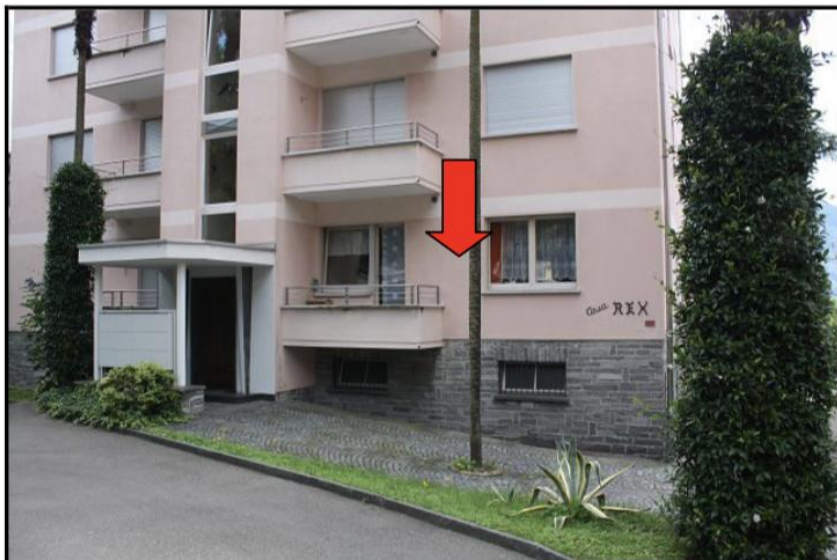
Entrata e balcone della cucina / Eingang mit Küchenbalkon
