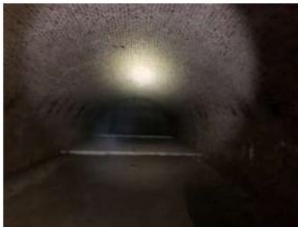
Ende des Kellers Nr. 4 (mit betonierter Bühne)
